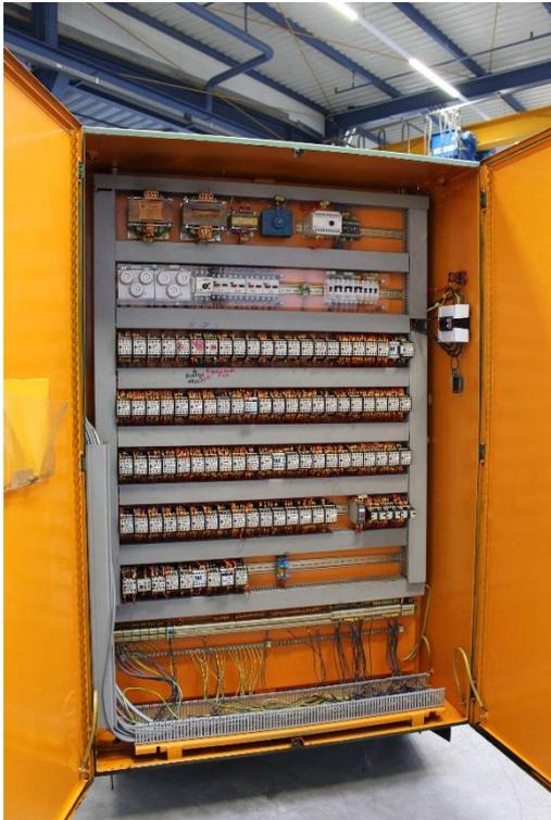
Elektro Schaltschrank an der Hydraulik befestigt
